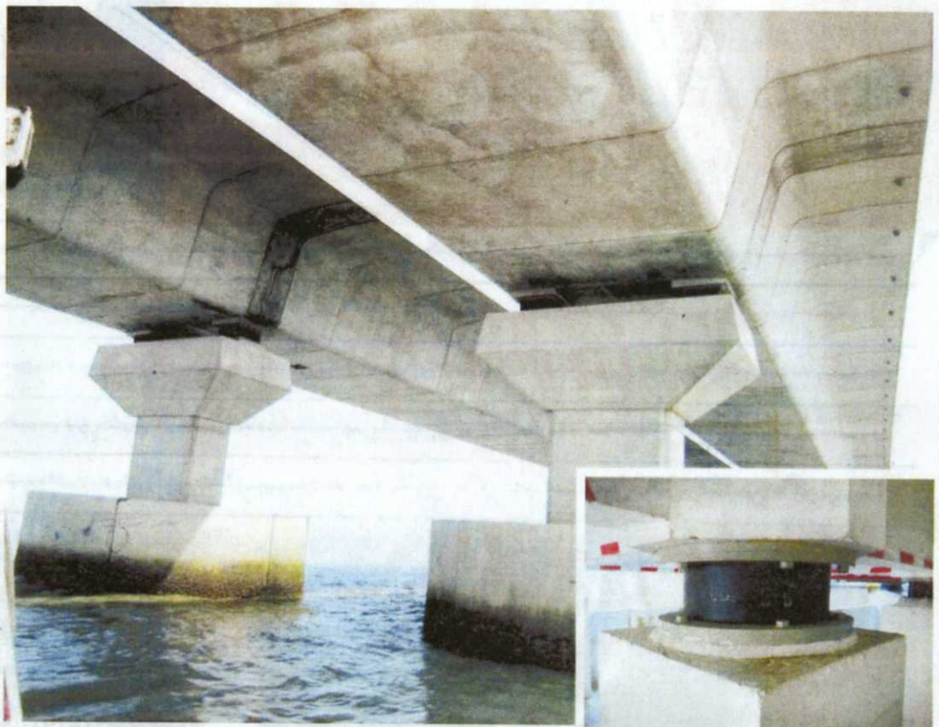
INOVASI gelas getah seismik dipasang pada Jambatan Sultan Abdul Halim Muadzam Shah bagi menyerap kesan gegaran akibat gempa bumi.
