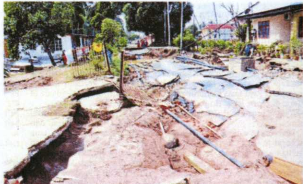
Jalan utama ke Pantai Cahaya Bulan dan bandar Kota Bharu terputus akibat kesan arus deras banjir. (FOTO NIK ABDULLAH NIK OMAR/BH)
