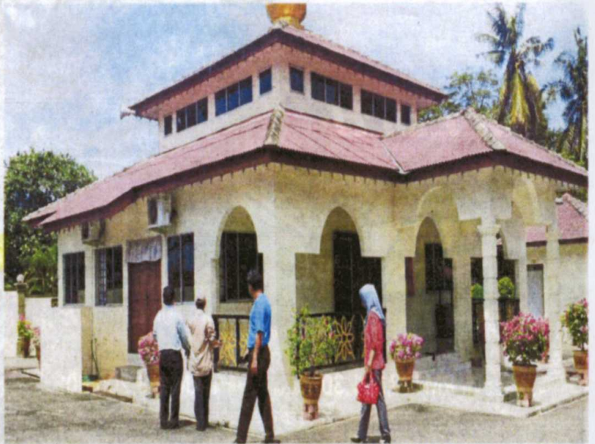
Tapak projek pemasangan sistem solar PV di Surau Nur Hidayah, Kampung Solok Biak di Tanjung Kling, Melaka.
