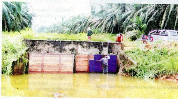
Pemasangan 'flap gate' menjadi penyelesaian jangka pendek untuk mengurangkan aliran air sungai masuk ke dalam kampung.
