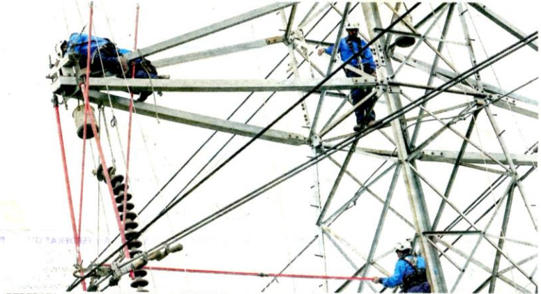
BEBERAPA pekerja Unit Talian Hayat (UTH) TNB melakukan kerja-kerja menukar penebat porselin di talian penghantaran menara setinggi kira-kira 30 meter yang menghubungkan Pelabuhan Klang ke Bukit Raja, Selangor.
