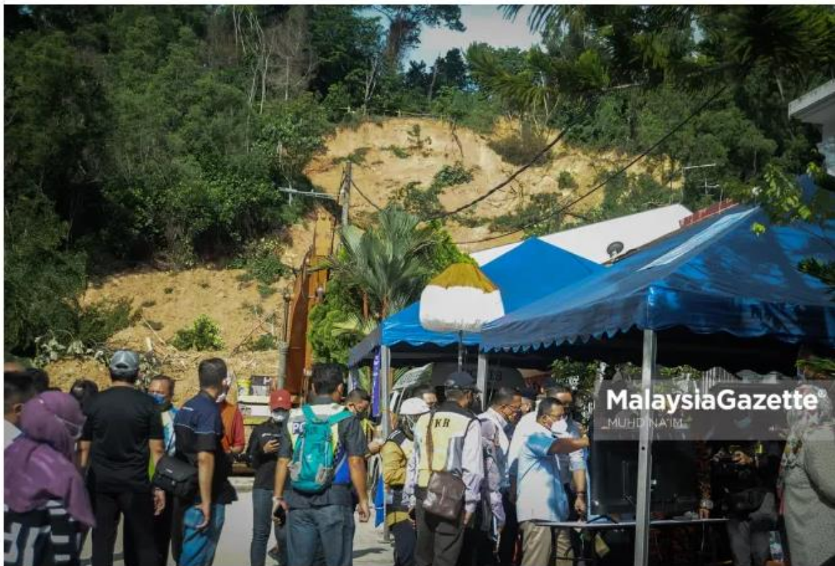
Keadaan lokasi kejadian tanah runtuh di Taman Bukit Permai 2 Ampang, Kuala Lumpur. Foto MUHD NA'IM, 11 MAC 2022.
