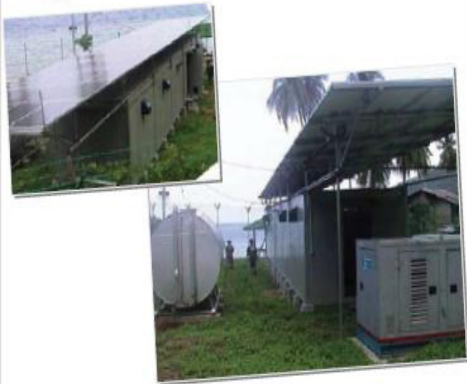
Solar hybrid power-generation station, Kampung Pak Kaleh, Pulau Pemanggil
